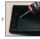
Anschließend wird der Endboden-Falz von innen mit einer Kleberaupe wasserdicht versiegelt.
