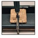
Rinnenverbindung mit einer Zwinge verpressen. Anschließend an der Rinnenwulst eine Niete zur Fixierung setzen.
