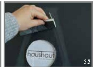
4. Klebepbereiche mit **haushaut-Haftreiniger** säubern und ablüften lassen (Dachfläche und Klebeflansch).
