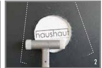
2. Loch aus dem Blech und der Unterkonstruktion mittels Lochsäge ausschneiden. 7-10 mm Bördelrand aufstellen.
