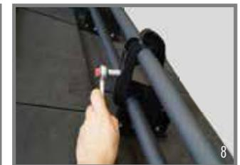
9. Schneefangrohre im Stoßbereich mittels Verbindungsmuffen verbinden. Um auftretende Längenausdehnungen aufnehmen zu können ist ein Zwischenraum von 15 mm vorzusehen.
