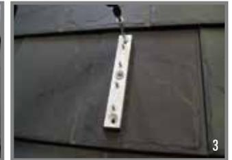
3. Grundplatte mit 3 Schrauben (8 x 140 mm) in den Sparren befestigen. (min. 32 mm Eindringtiefe in den Sparren)
