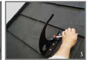
5. Sicherheitsdachhaken auf die Grundplatte stecken und mit den mitgelieferten Muttern befestigen (Drehmoment 20 Nm)
