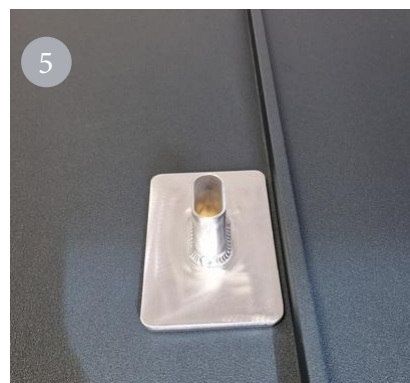
Bohrloch sollte min. 4cm Durchmesser haben!
