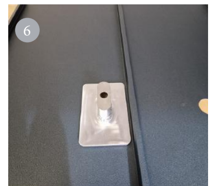
Einlegen der Gleitscheibe
